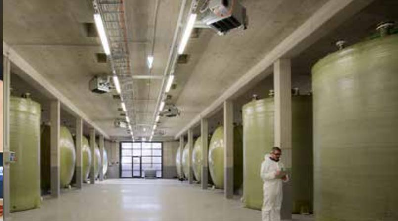
Elektrolyttanks der größten Redox-Flow-Batterie Deutschlands. © Fraunhofer ICT
