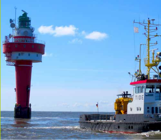
Prüfstand Leuchtturm »Alte Weser« mit Korrosionsproben im küstennahen Schifffahrtsbereich. © Fraunhofer IFAM
