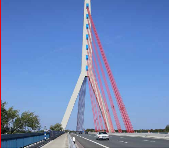
Brücke als Beispiel eines Infrastrukturbauwerkes. © Fraunhofer IZFP
