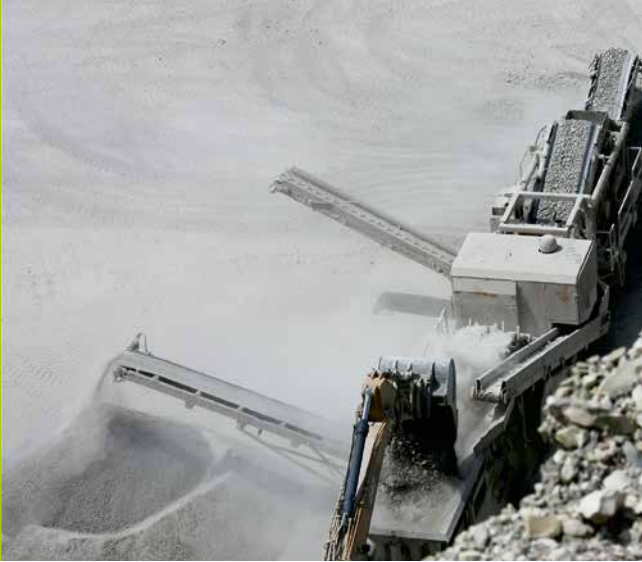
Fraunhofer-Expertise zur Sortierung von heterogenem Bauschutt, um homogene Bauprodukte und Sekundärrohstoffe herzustellen. © Fraunhofer IBP
